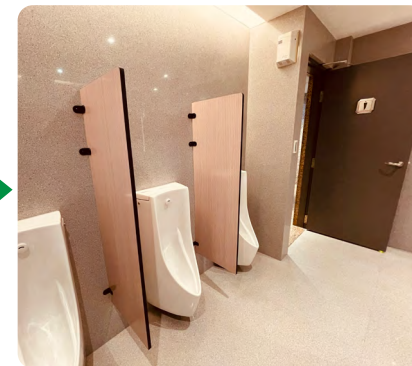
▲ 將舊有石材拆下後，經過破碎、過篩及重新壓製成再生石英石，重新鋪設於原空間，根據混和原料的不同，再生石英石的紋路可以多樣性呈現，並且具備大面積使用的彈性，適合作為建材使用。
