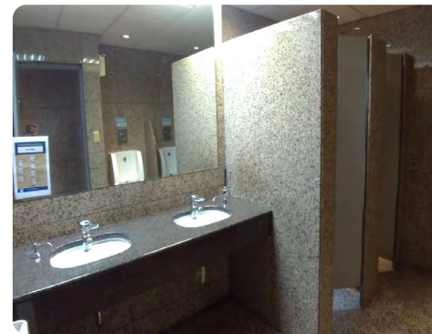
▲ 將舊有石材拆下後，經過破碎、過篩及重新壓製成再生石英石，重新鋪設於原空間，根據混和原料的不同，再生石英石的紋路可以多樣性呈現，並且具備大面積使用的彈性，適合作為建材使用。
