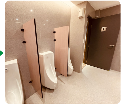
▲ 將舊有石材拆下後，經過破碎、過篩及重新壓製成再生石英石，重新鋪設於原空間，根據混和原料的不同，再生石英石的紋路可以多樣性呈現，並且具備大面積使用的彈性，適合作為建材使用。
